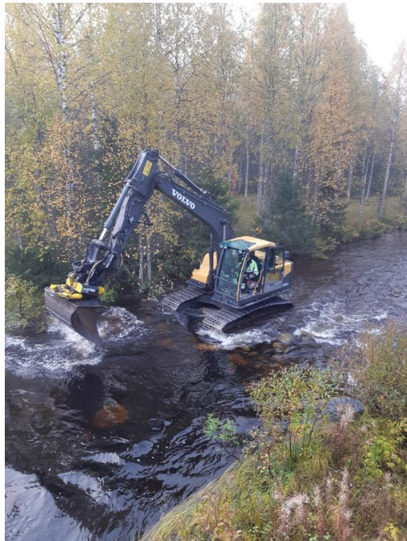
Kuvat 10. ja 11. Kutusoran läjitysalue ja kosken kiveämistä Myllykoskella.
